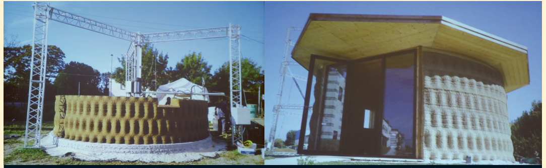
Présentation par S. Le Follic-Hadida de la construction 3D des premières maisons en argile réalisées en septembre 2018 par Wasp Company par cette technique
